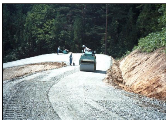
工事用運搬道路
