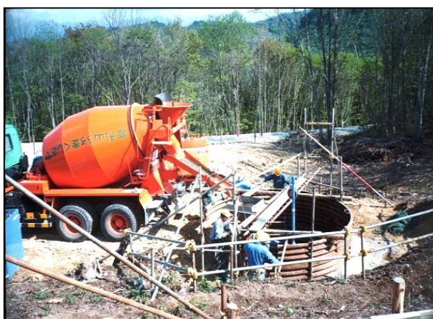
鉄塔工事－基礎工事
