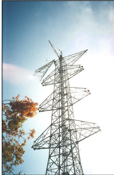
鉄塔工事—組立工事
