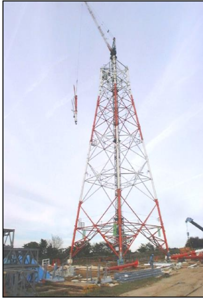
鉄塔工事—組立工事
