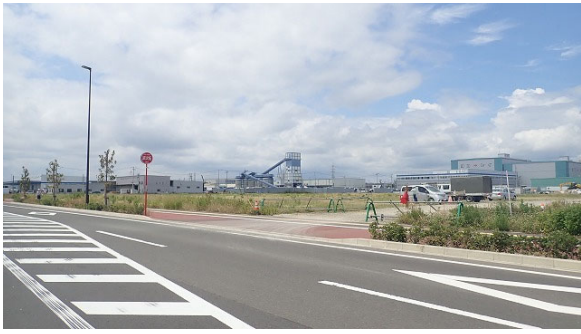
①計画地南東端より北西方向
