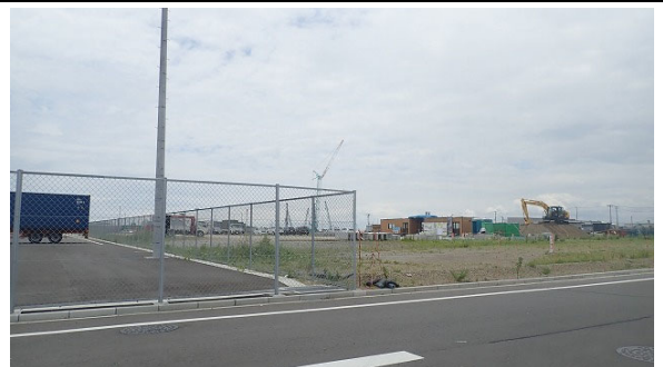
⑧計画地北東端より南西方向
