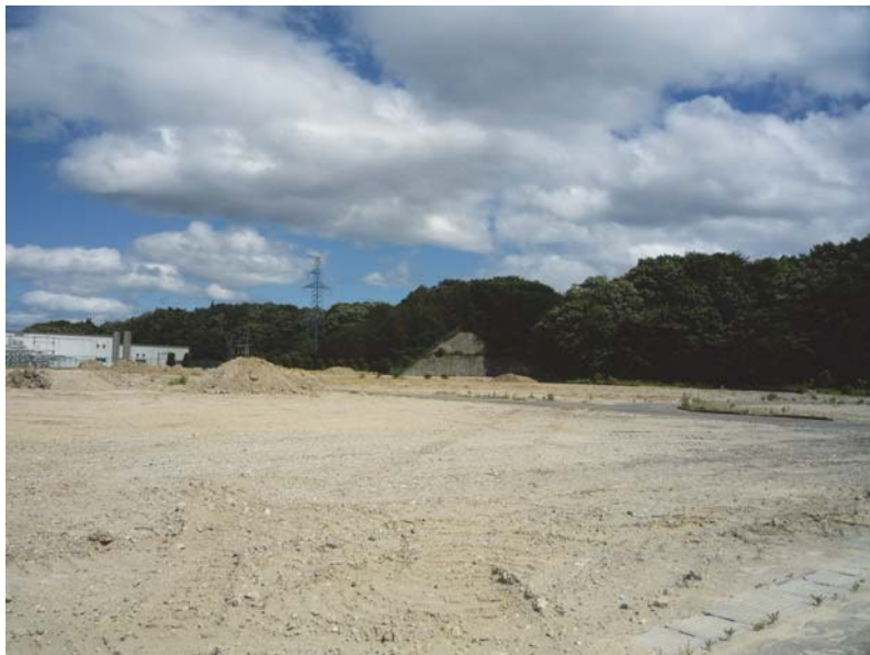
写真1-3 計画地内の様子（計画地北西角付近から南東を望む） （平成27年6月4日撮影）
