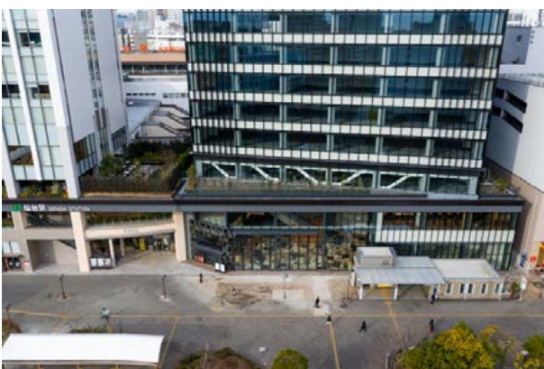
業務施設屋上（東側上空から西方向）
