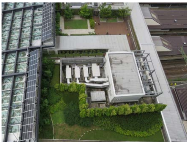
商業施設 5 階庭園（宿泊施設側から西方向）
