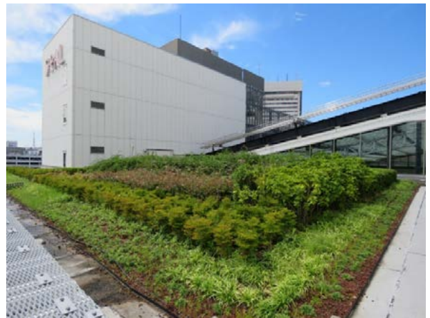
東西自由通路屋根部分
