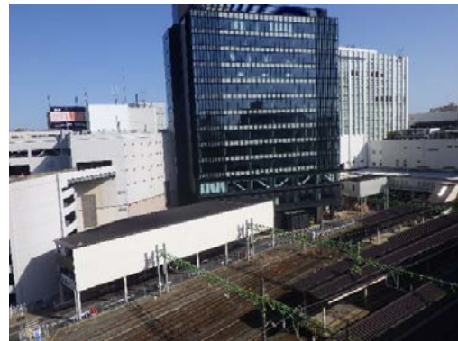
④駅屋上からの状況(東口)
