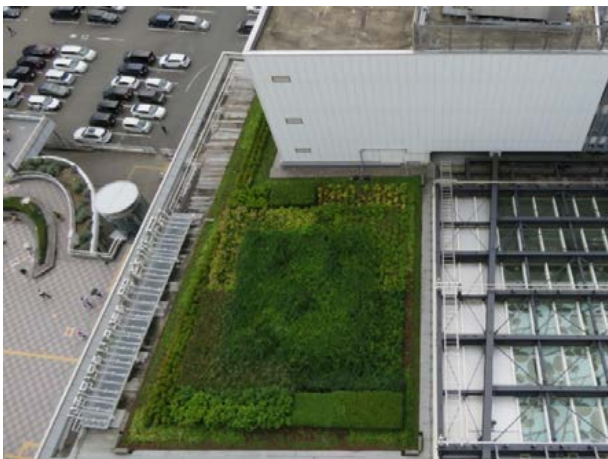
東西自由通路屋根部分（宿泊施設側から南方向）
