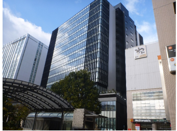
②駅前広場北側よりオフィス棟全景
