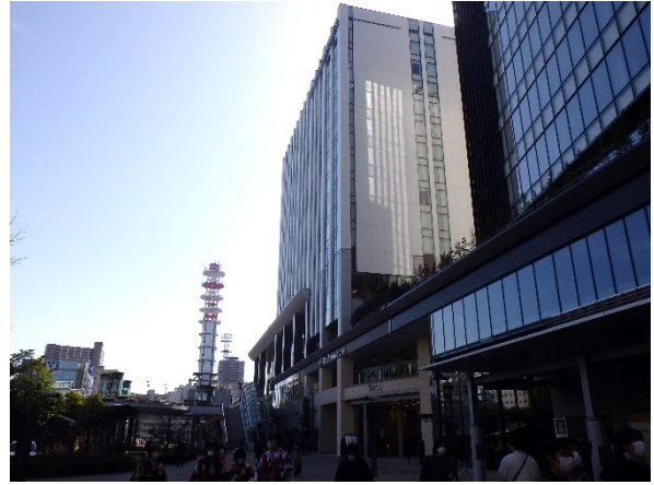
② 駅前広場北側より全景
