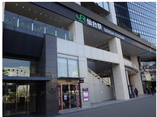
④ 駅前広場より低層部
