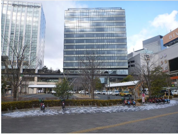
①駅前広場よりオフィス棟正面
