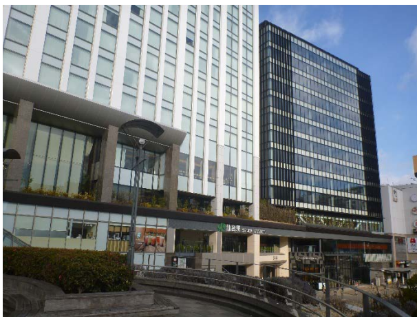
③ペデストリアンデッキよりオフィス棟全景
