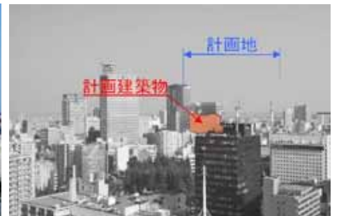
(建築物の視認状況)
