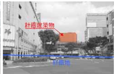
(建築物の視認状況)
