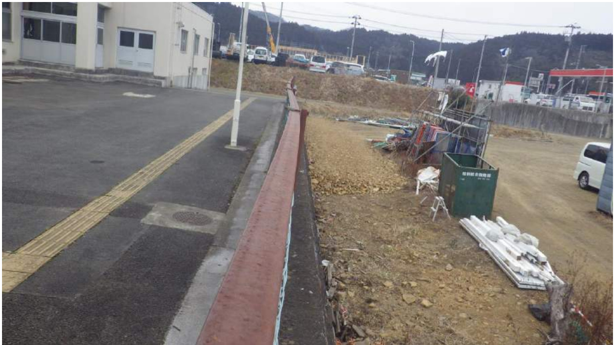
写真 7-2-2 調査地点（擁壁天端）
