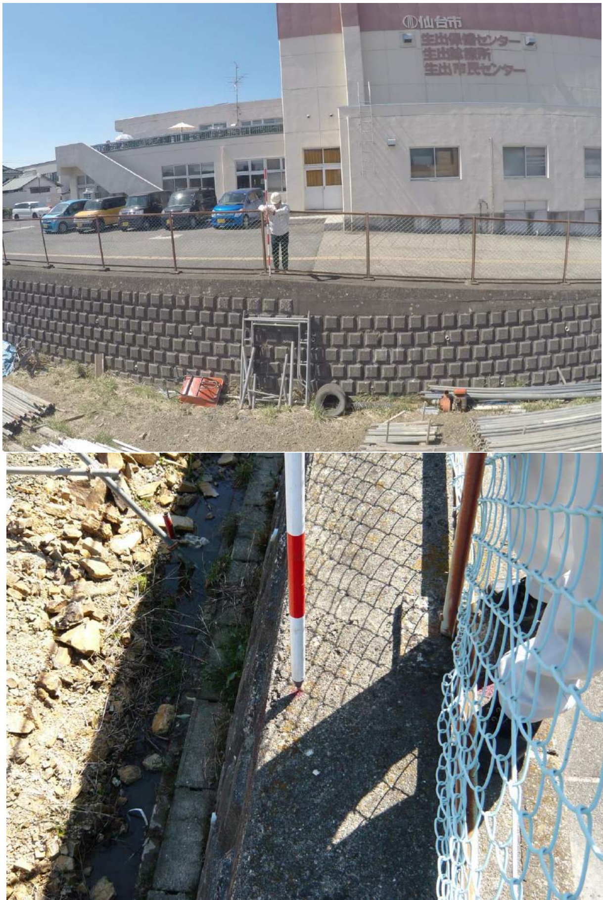
写真 7-2-1 調査地点（擁壁天端）
