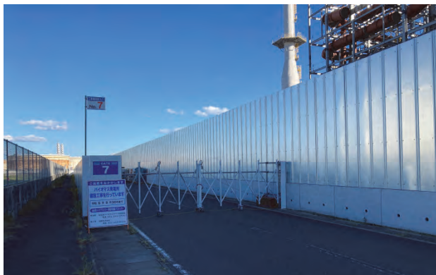
仮囲いの設置状況
