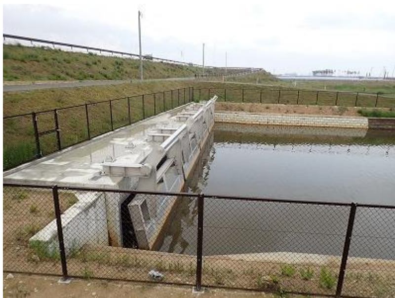
写真 2.5-1 フラップゲートの設置状況（二郷堀）
