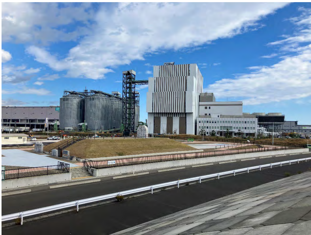
第 1-6 図 発電設備の外観
