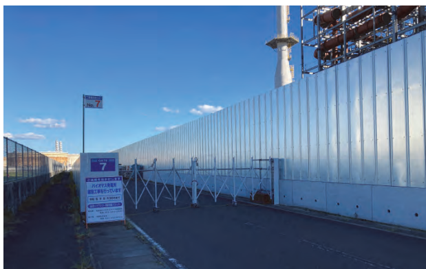
仮囲いの設置状況
