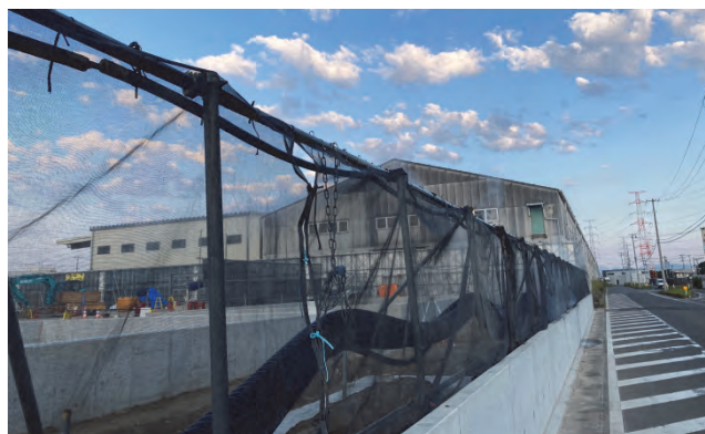
防じんネット設置状況 粉じん飛散防止ミスト噴霧の状況
