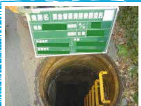
きれいなマンホール
