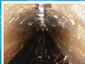
きれいな下水道管
