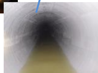
工事完了後の管内の様子
