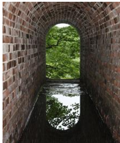
仙台市煉瓦下水道「杜の都れんが下水洞窟」
