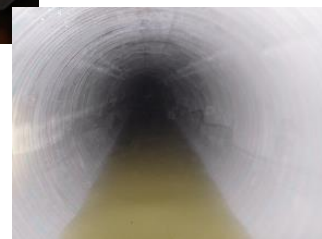
工事完了後の管路内の様子
