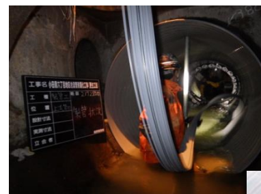
下水道管路の耐震化工事の様子
