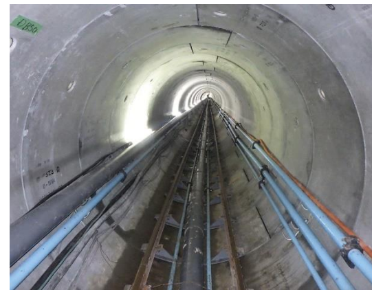
(建設中の雨水排水施設)
