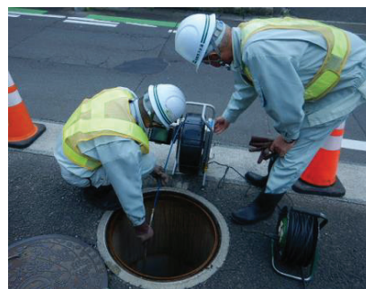
管路施設の調査
