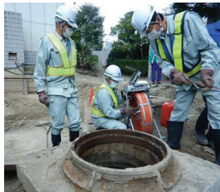
管路施設の点検
