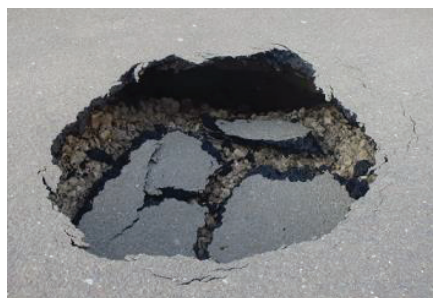
管路施設の不具合を起因とした道路陥没
