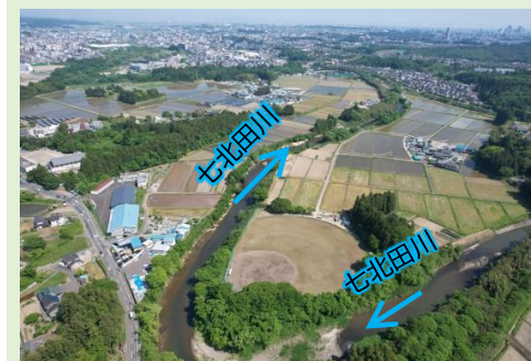
令和6年度施工箇所
