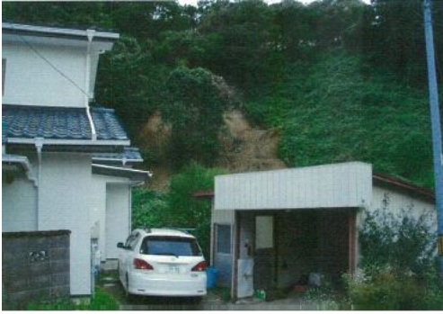
太白区三神峯：人家裏の斜面崩壊
