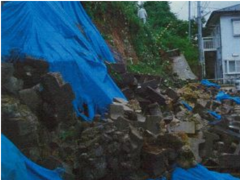
宮城野区東仙台：人家裏の法面崩壊
