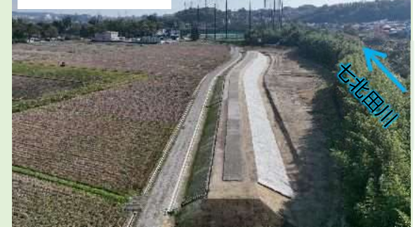
令和6年度施工箇所
