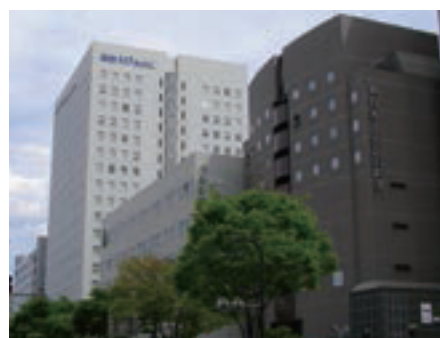
建築設備等が直接見えないよう配慮した建築物
