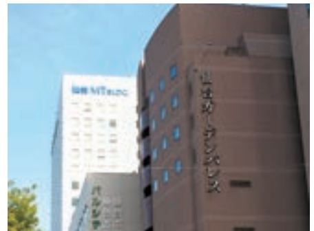
独立文字によるシンプルな屋上広告物・壁面広告物
