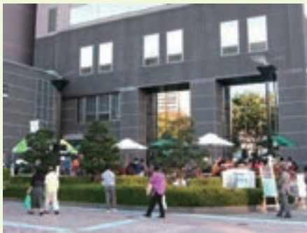
宮城野通に面して壁面を後退させセミパブリックスペースを配置した建築物
