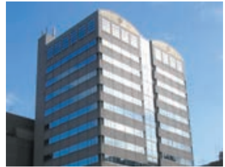
形態や素材で壁面の分節化を行った建築物
