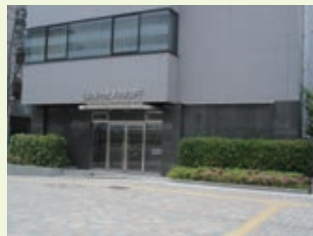
1階部分のセットバックにより生み出されたスペースを植栽により緑化した建築物
