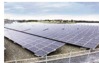
大沼太陽光発電所
