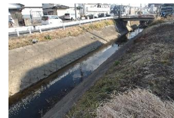
水路土砂浚渫後
