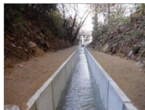
水路整備施工後
