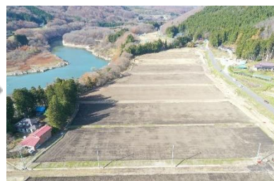
大倉日向地区 整備後
