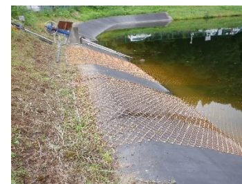
安全ネット設置状況
