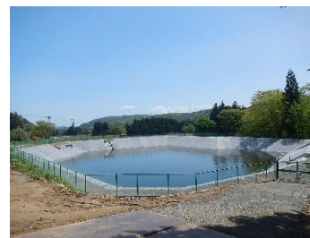
ため池改修状況
