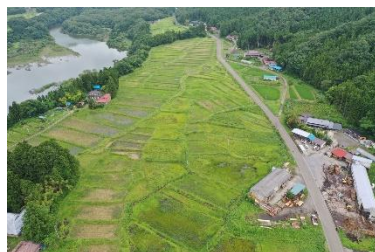
大倉日向地区 整備前
