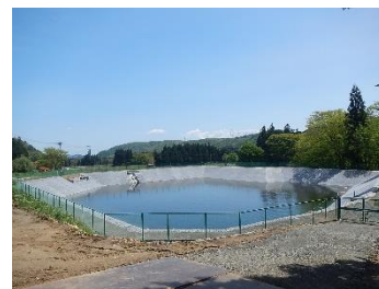
ため池改修状況
