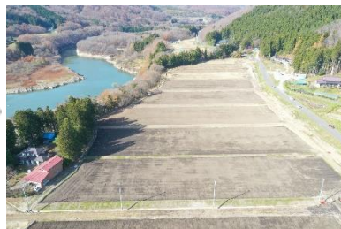
大倉日向地区 整備後
