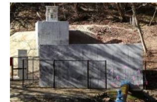
朴沢小水力発電所
