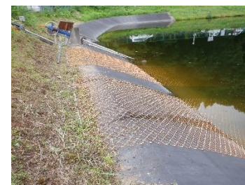
安全ネット設置状況
