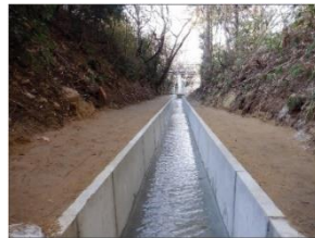
水路整備施工後
