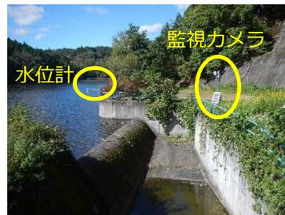
監視カメラでため池の状況および水位を執務室で監視する
