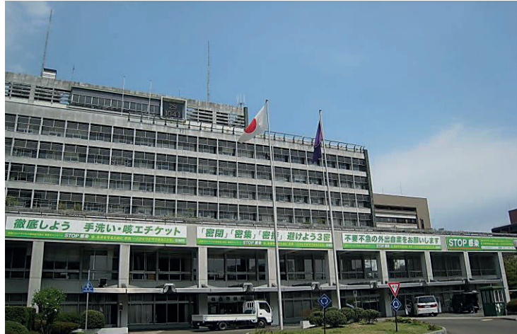
市役所本庁舎の吊看板
