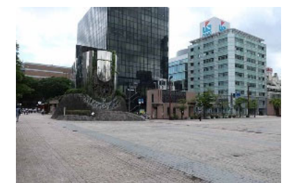
⑥隣接する建築、換気塔、地下駐車場入口 南側は植栽が少なく、各種施設が錯綜
