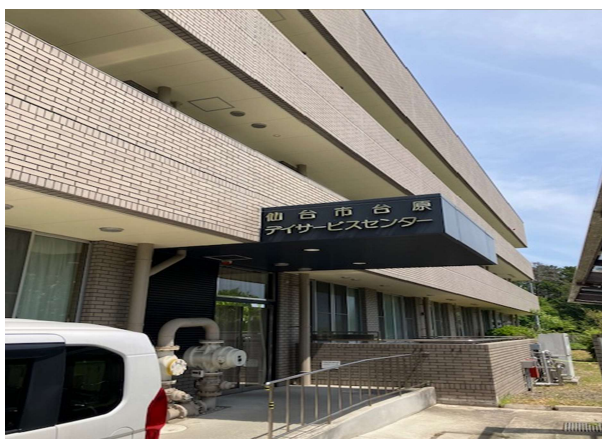
台原デイサービスセンターの外観
