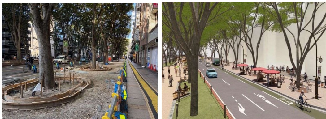
図 121 定禅寺通再整備工事状況、再整備後のイメージ
