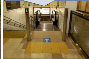
エスカレーター、誘導案内設備設置
