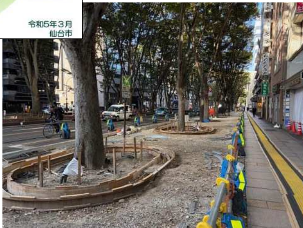
定禅寺通再整備 工事状況
