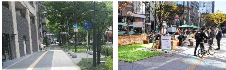
図 123 青葉通における道路空間の再構成と利活用の事例
