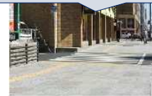
段差や勾配が改善された歩行空間
