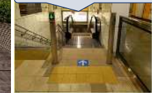
エスカレーター、誘導案内設備設置
