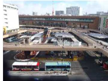
図 93 駅前広場再整備事業が進む 仙台駅西口
