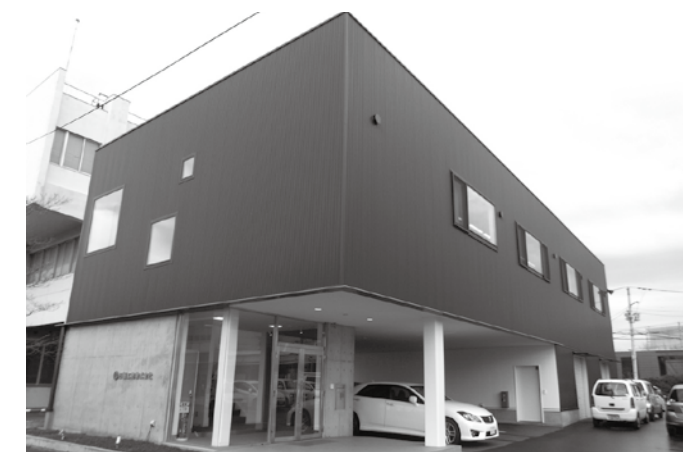
▲日振工発(株) 東北支店外観
