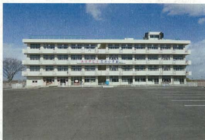
震災遺構 仙台市立荒浜小学校
