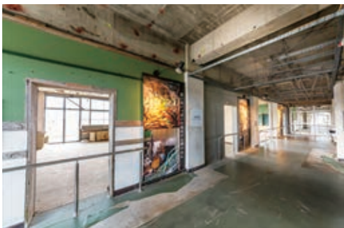
震災遺構「仙台市立荒浜小学校」
