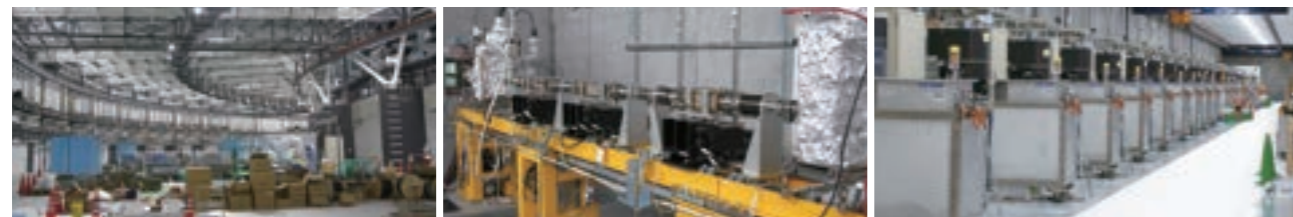
photo:施設内観(建設中)
