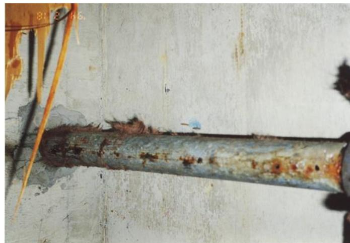
水道用亜鉛めっき鋼管は、寸法を測り現場でネジをきり、それをねじ込むことで接続していた。技量が問われる。
