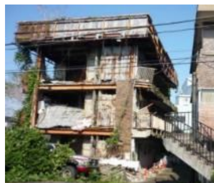
▲ 管理が適切に行われず、外壁等が崩落した他都市のマンションの事例 (国土交通省資料より引用)
