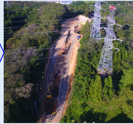
進捗写真【北から南側を撮影】 (上空から撮影) R1.9.19
