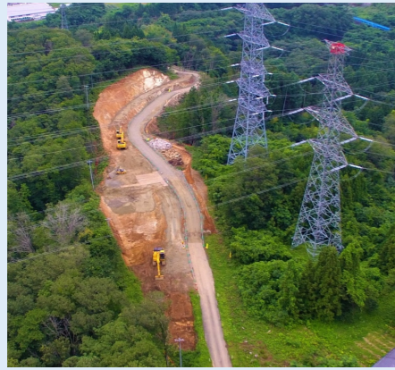
進捗写真【北から南側を撮影】 (上空から撮影) R1.7.20
