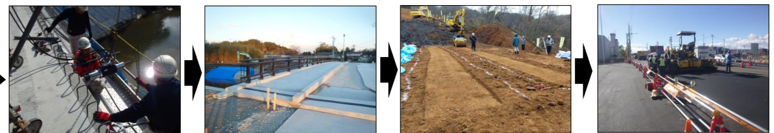
⑤横組工(橋桁の連結) ⑥橋梁付属物工 ⑦盛土工 ⑧アスファルト舗装工
