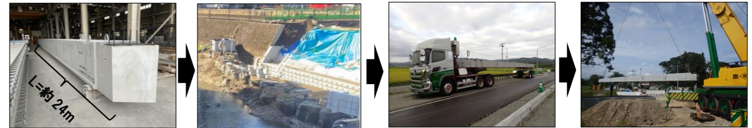
①橋桁製作(亘理町の工場) ②護岸整備 ③橋桁の運搬(亘理町→現場) ④橋桁の架設
