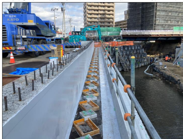
写真②:支承設置箇所(対岸側の橋台も同様です。)
