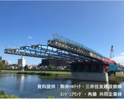
A1橋台～P1橋脚間 送出し架設
