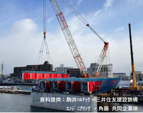
A1橋台～P1橋脚間 送出し架設
