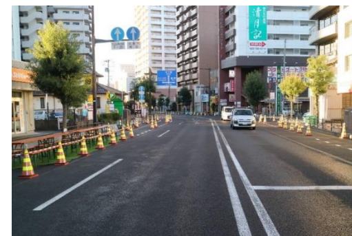
旧国道4号の交通規制(4車線のうち、歩道側2車線を規制)
