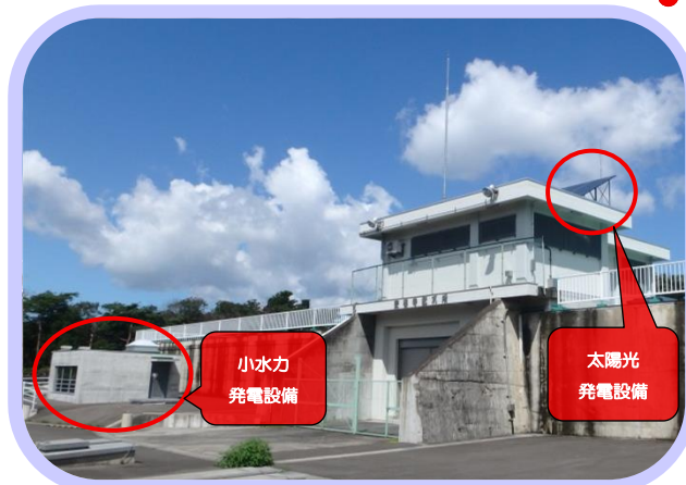
▲安養寺配水所 東仙台地域に水を供給するための配水所です。環境に配慮するため、小水力発電設備や太陽光発電設備が設置されています（下写真）。
