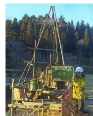
ボーリング調査イメージ
