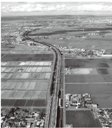
仙台東部道路上空からのほ場整備状況
