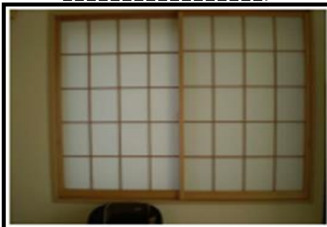
窓の確認がとれない
