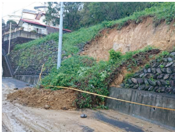
本市における土砂災害(かけ崩れ)の被害 (令和元年東日本台風)
