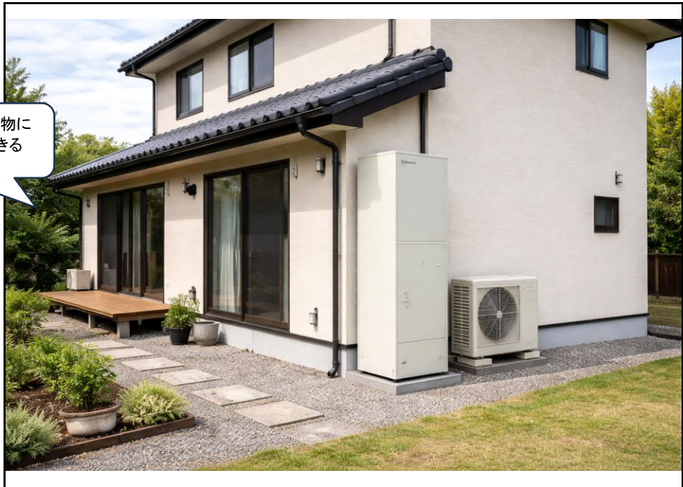
【工事後】 ②設備設置後の全体写真
