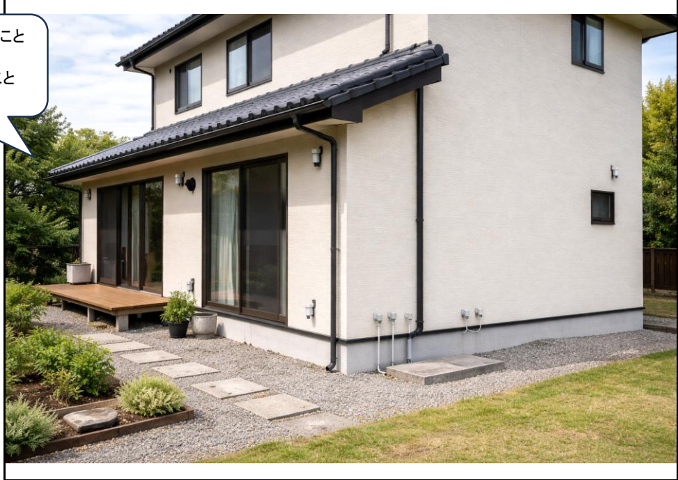
【撤去後】 ①対象設備撤去後写真
