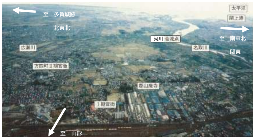
図 2-2 郡山遺跡周辺から太平洋を望む（昭和 62 年撮影）（西から撮影）
