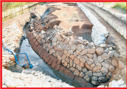
舟溜りの入口に造られた石積み(北から)
